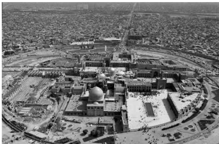
عملیات عمرانی توسعه شهری حرم امام رضا Construction operations for the urban development of Imam Reza Shrine
