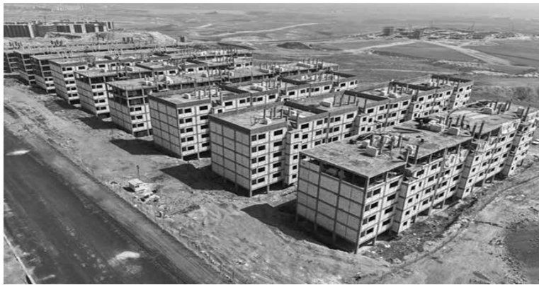
آغاز احداث برج‌های مسکونی «نهضت ملی مسکن» از ۱۴۰۱
